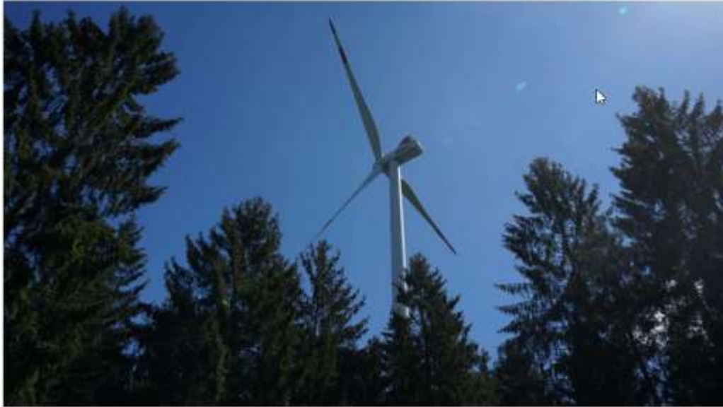
So ähnlich könnte es auch im Rhödaer Holz bald aussehen: Fünf Windenergieanlagen plant dort das Unternehmen Innovent in Zusammenarbeit mit der Gemeinde Breuna. Die Windräder sind knapp 240 Meter hoch. (Symbolfoto) © Jens Doll
