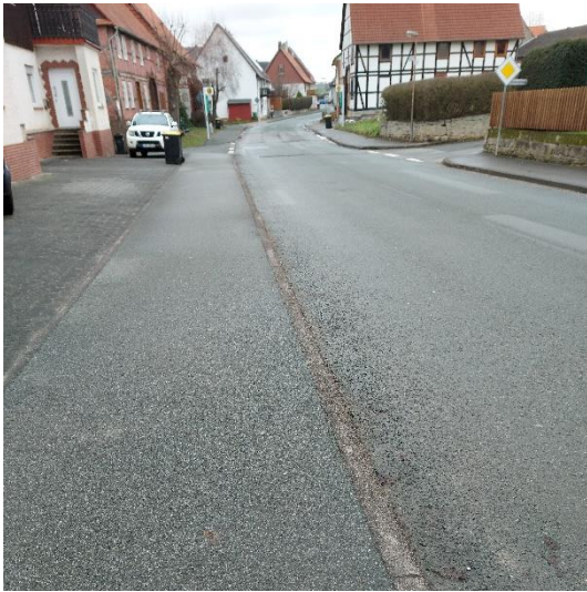
Abbildung 26: Obere Straße mit niedrigem, abgerundetem Bordstein links und erhöhtem Bordstein rechts, Bild: B.A.U.M.
