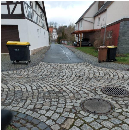
Abbildung 28: Kreuzung Untere Str. Ecke Wiesenstr. mit Pflastersteinbelag, Entwässerungsrinnen und Mülltonnen, Bild: B.A.U.M.
