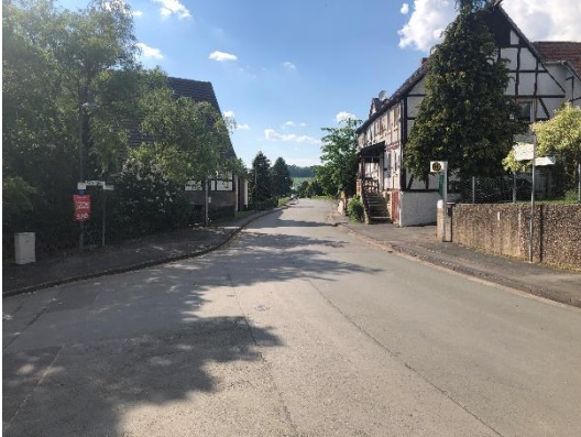
Abbildung 27: Alsbergstraße Ecke Am Dorfplatz mit Bushaltestelle Rhöda und Wegweiser für Radfahrer. Keine Gehwegabsenkung im Kreuzungsbereich, Bild: BAUM
