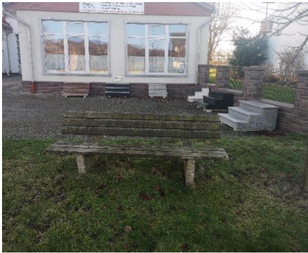
Abbildung 29: Sanierungsbedürftige Sitzgelegenheit an der Westseite der Holländischen Straße
