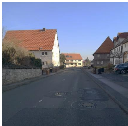
Abbildung 28: Auch auf den Wegen zu den Bushaltestellen „Niederlistingen“ befindet sich kein ausgewiesener oder Barrierefreier Übergang
