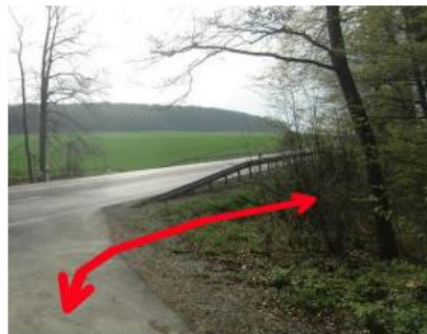
Bild 2: Am Ende des Forstweges von Obermeiser kommt: Beginn des Lückenschlusses entlang der B 7.
