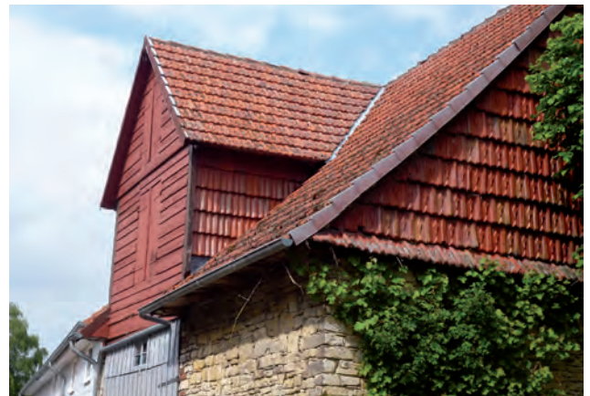
Gebäude aus Bruchstein mit Dach und Behang aus roten Tonziegeln, Wettasingen
