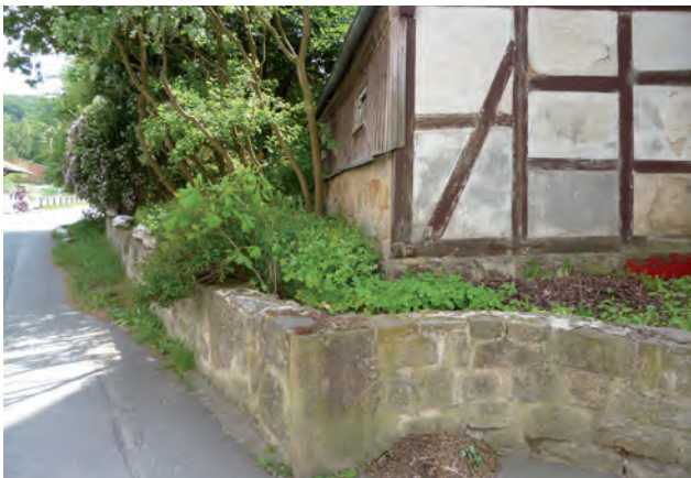
Fachwerk mit Sockel und Einfriedung aus Naturstein, Niederlistingen
