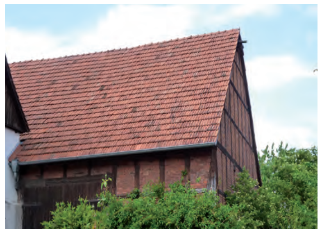
Ausgemauerte Gefache an einem Wirtschaftsgebäude, Oberlistingen
