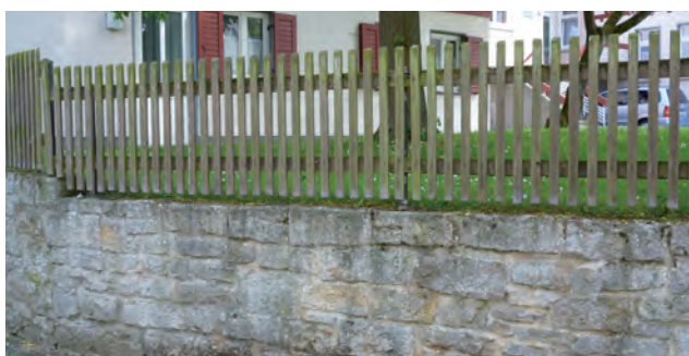
Natursteinmauer mit Staketenzaun, Oberlistingen
