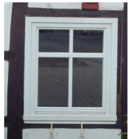
Einflügeliges Fenster, viergeteilt, Breuna
