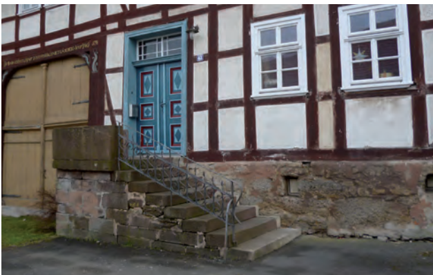
Eingangsbereich mit seitlicher Treppe, Niederlistingen
