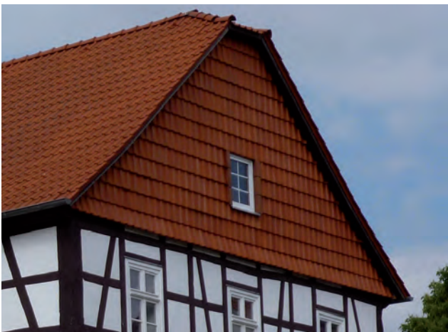
Geringer Dachüberstand, Breuna
