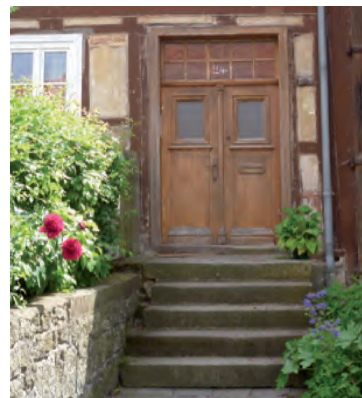
Eingangsbereich mit Treppe, Niederlistingen
