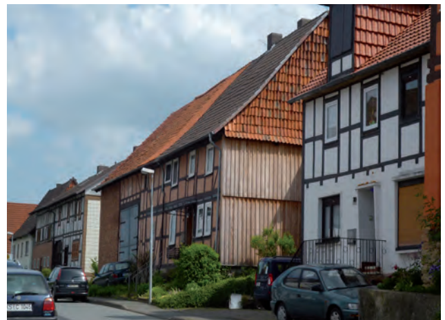
Zufahrt von der Straße und seitlich der Gebäude, Oberlistingen
