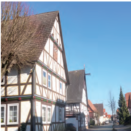
Gliederung der Fassade durch Fachwerk und Fenster, Wettesingen
