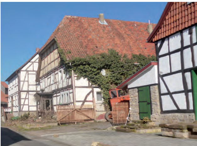
Hofzufahrt mit Staketenzaun, Wettesingen
