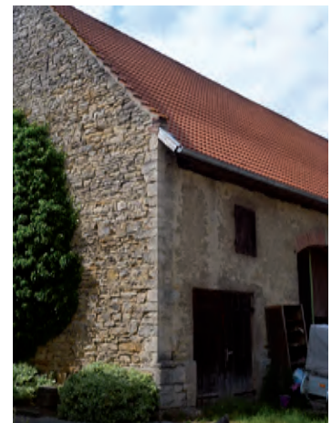
Scheune aus Bruchstein, Wettesingen
